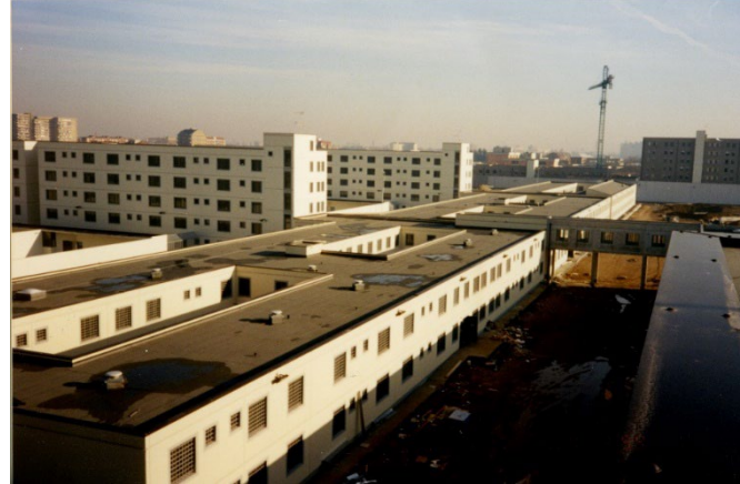
PRISON OF BOLLATE IN MILAN MINISTERO DELLA GIUSTIZIA Bollate, MI
