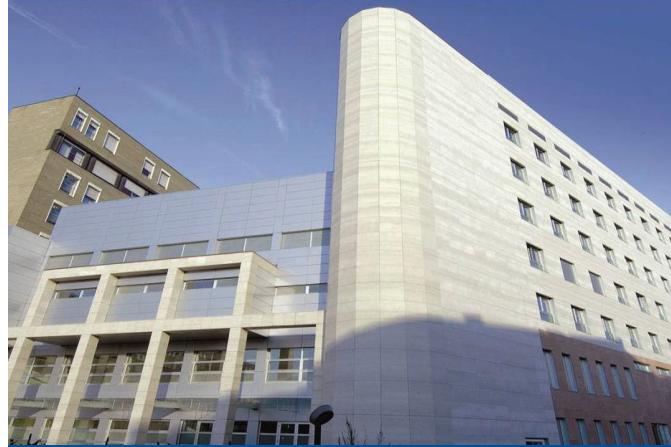
EXPANSION OF SAN DONATO HOSPITAL GRUPPO SAN DONATO Milan
