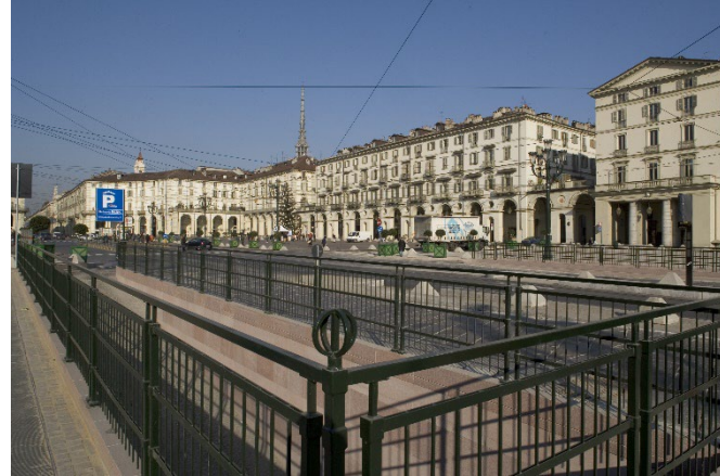
UNDERGROUND CAR PARK IN VITTORIO VENETO SQUARE PARCHEGGIO PIAZZA VITTORIO VENETO SRL Turin
