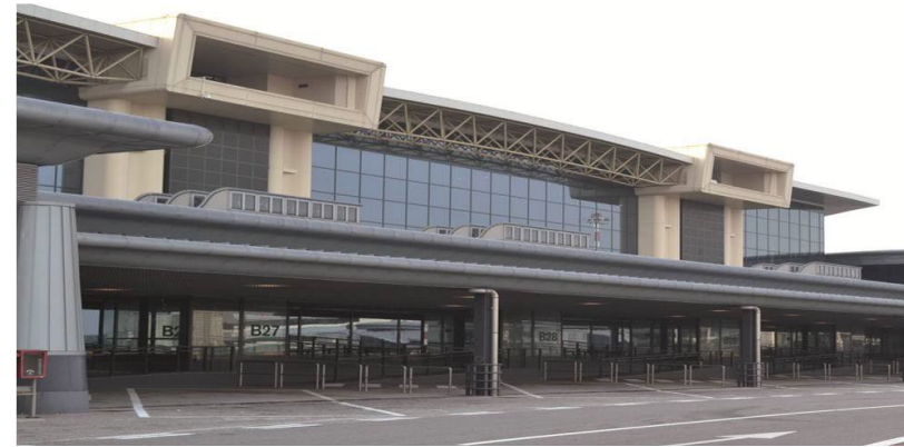
Cliente: S.E.A. S.p.A. Progetto: Realizzazione dei piazzali, viabilità di servizio, ampliamento del terminal, costruzione della Palazzina ENAC - Aeroporto di Milano Malpensa - Terminal 1
