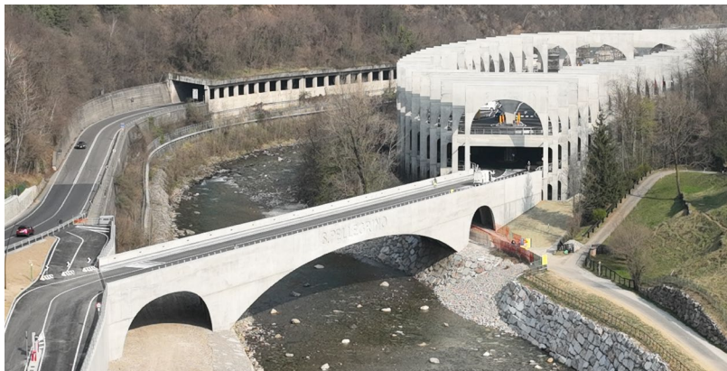
Cliente: San Pellegrino S.p.A. Progetto: San Pellegrino Nuova Flagship Factory - Zogno (BG)
