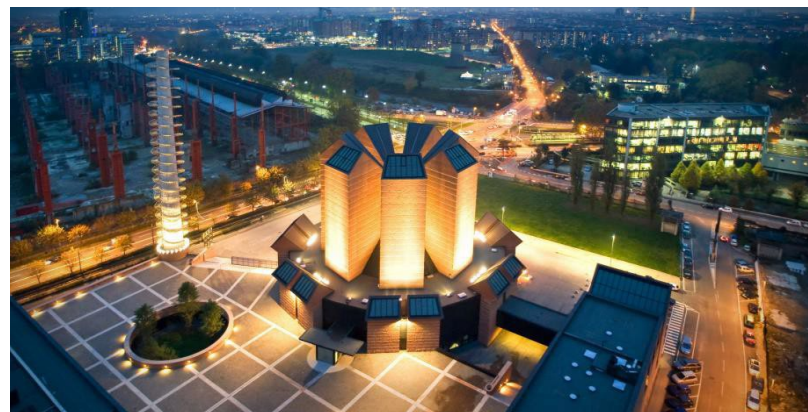
Cliente: Chiesa del Santo Volto Progetto: Costruzione della Chiesa del Santo Volto - Torino
