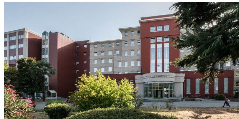
Cliente: ASL 3 TO COLLEGNO Progetto: Ristrutturazione e ampliamento ospedale "E.Agnelli" - Pinerolo - Torino
