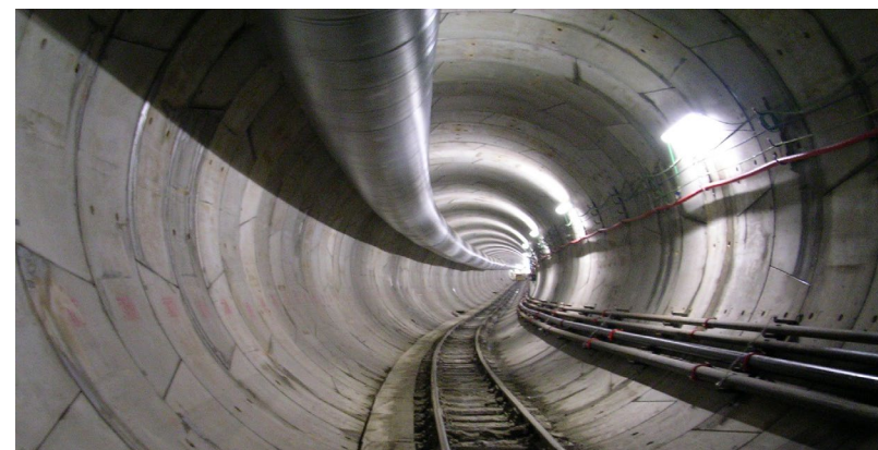
Cliente: M.N. Metropolitana di Napoli S.p.A. Progetto: Realizzazione opere tratta Dante - Garibaldi, deposito e officina Secondigliano, stazione Piazza Dante e corridoio Montesano - Linea 1
