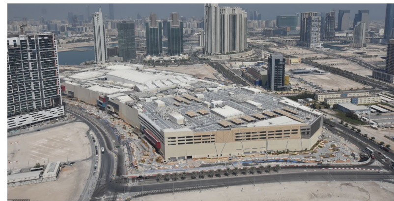
Cliente: AL FARWANIYA PROPERTY Progetto: Costruzione del Centro Commerciale Reem Mall – Abu Dhabi, EAU
