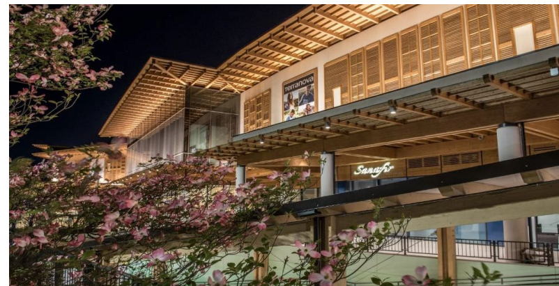
Cliente: T.E.A. S.p.A. Progetto: Costruzione del Centro Commerciale di Arese - Milano
