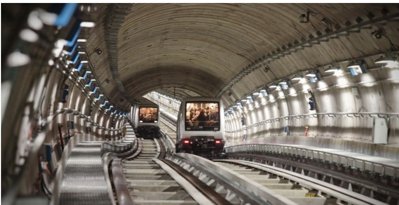
Cliente: Gruppo Torinese Trasporti S.p.A. Progetto: Costruzione della Metropolitana Automatica di Torino Lotti 3 e 5 - tratta Collegno-Porta Nuova (tunnel 5.300 m)
