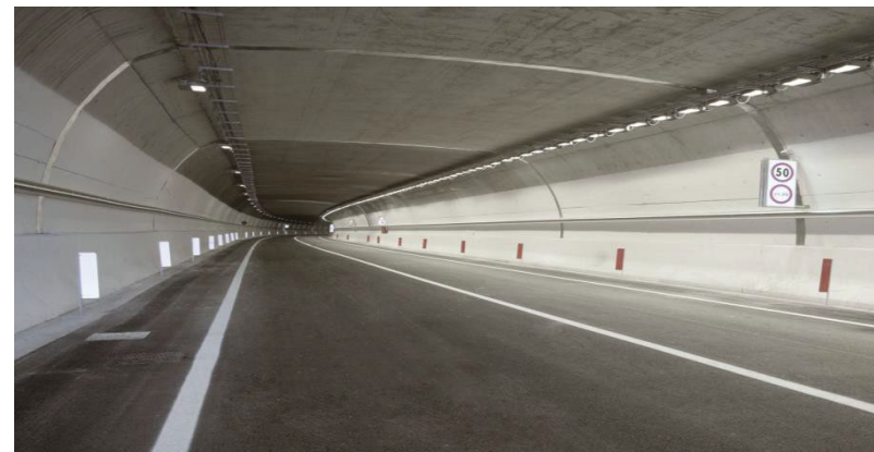
Cliente: Turin Agency 2006 Progetto: Realizzazione della Galleria di Avigliana (tunnel 1.750 m) - Avigliana (Torino)
