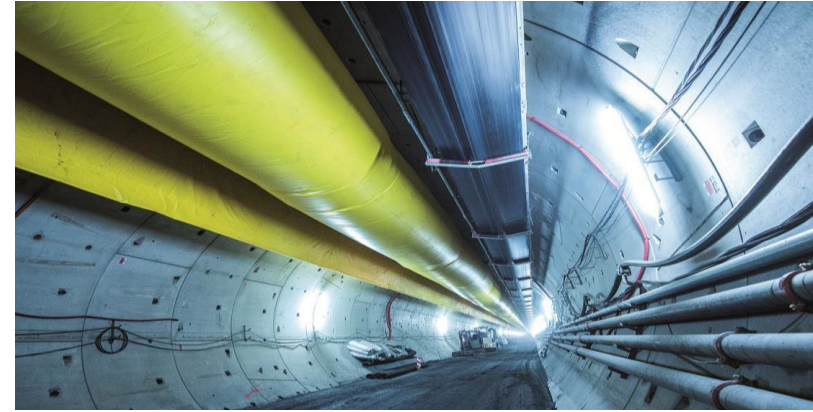
Cliente: S.I.T.A.F. S.p.A. Progetto: Costruzione della Galleria di sicurezza del Frejus-Bardonecchia (Torino)
