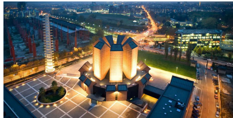
Cliente: Chiesa del Santo Volto Progetto: Costruzione della Chiesa del Santo Volto - Torino
