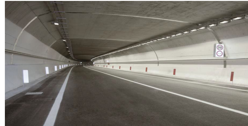
Cliente: Turin Agency 2006 Progetto: Realizzazione della Galleria di Avigliana (tunnel 1.750 m) - Avigliana (Torino)
