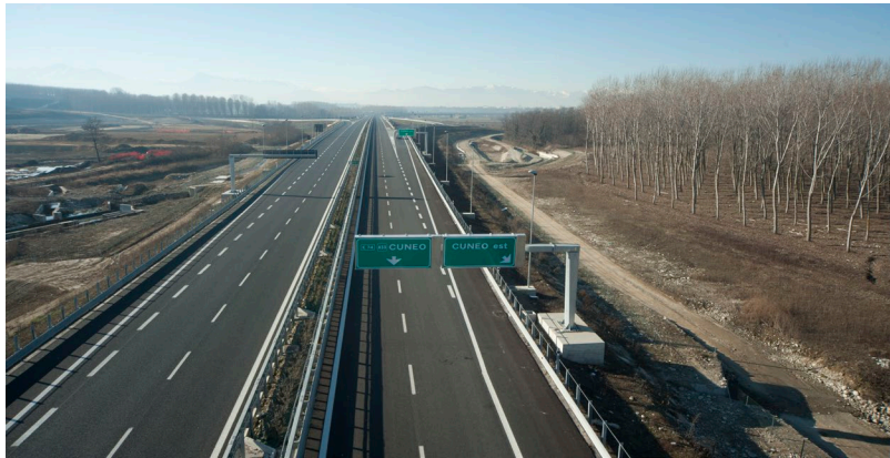
Ciente: ANAS S.p.A. Progetto: Costruzione dell'Autostrada A33 Asti-Cuneo Lotto 1.1
