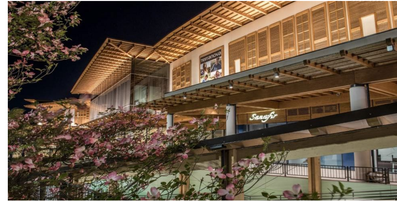
Cliente: T.E.A. S.p.A. Progetto: Costruzione del Centro Commerciale di Arese - Milano
