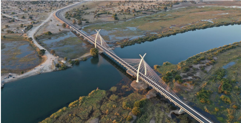
Cliente: Ministry of Transport & Communications - Roads Dept. Progetto: Costruzione del ponte sul fiume Okavango - Botswana
